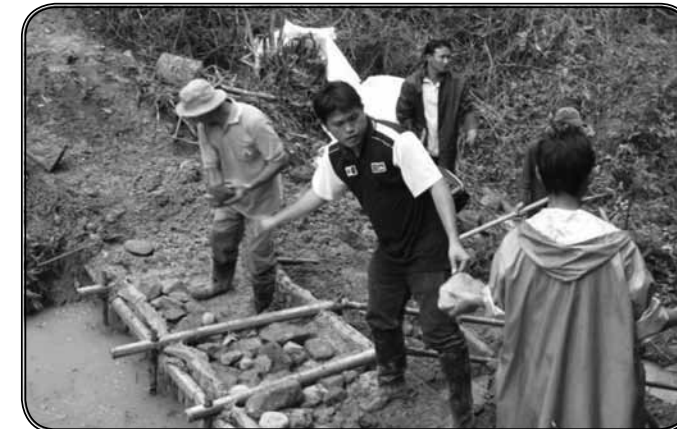
ภาพที่ 2 ประชาชนร่วมกันสร้างฝายกั้นน้ำ
